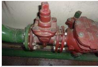
Ech n°129 : joint de bride amiantée
