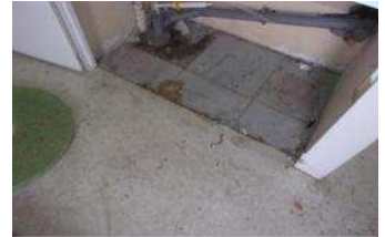
Ech n°118 : dalle de sol grise + colle noire amiantées
