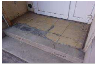
Ech n°44 : dalle de sol orange + colle noire amiantées
