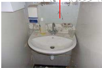
Ech n°112 : colle + joint des faïences blanches amiantées
