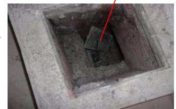
Ech n°120 : ventilation basse en amiante-ciment
