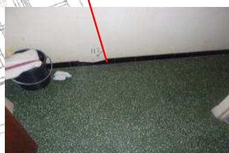
Ech n°112 : colle + joint des plinthes marrons amiantées
