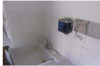
Ech n°117 : Colle + joint des faïences blanches amiantés
