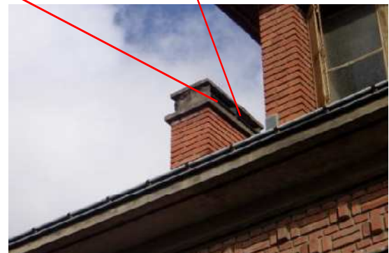
Ailettes des cheminées en amiante-ciment
