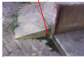
Conduit évacuation des eaux en amiante-ciment
