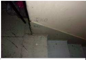
Ech n°159/160 : ragréage + plinthes marron amiantés
