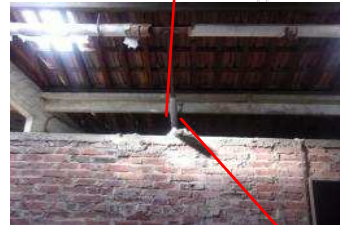
Calorifugeage gris cartonné amianté
