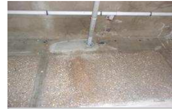
Bout de calorifugeage cartonné gris amianté
